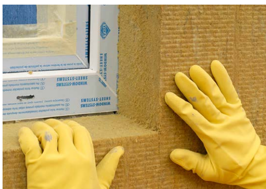
Langų ir durų kampuose naudojamos L forma išpjautos plokštės
