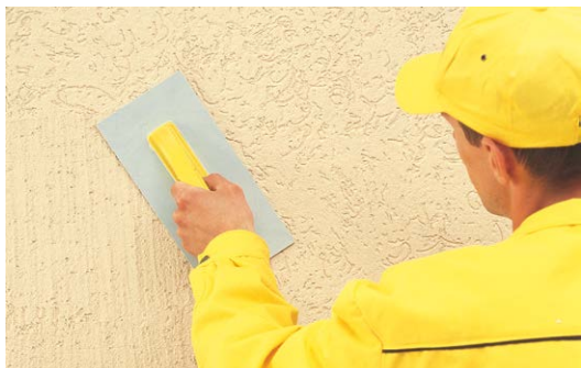
Naudojant kinivarpy tekstūros tinką galima sukurti įvairių raštų.
