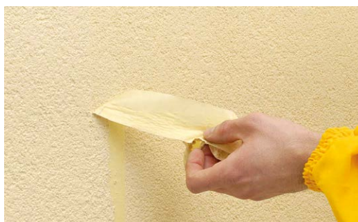
Nutraukus tinkavimą, sandūrą reikia suformuoti naudojant juostą.
