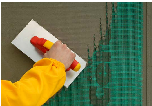
Tinklo atraižos dedamos ant armavimo mišinio, užtepto ant pagrindo
